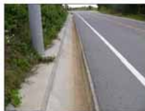
写真-2 片側傾斜型側溝
