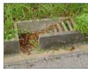
写真-3 スロープ付き側溝
