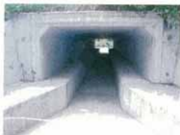
写真-6 ボックスカルバートの設置例
