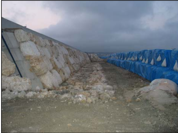
写真-2 外海との遮水完了の状況
