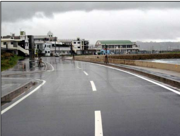
写真-3 完成後の状況
