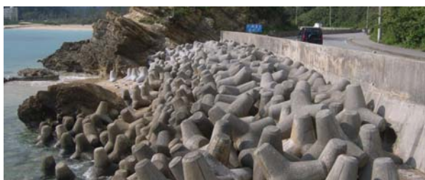
写真-4 消波護岸の整備状況
