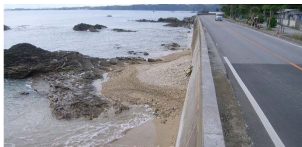
写真-5 直立護岸の整備状況
