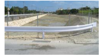
写真-5 暫定対策の整備状況
