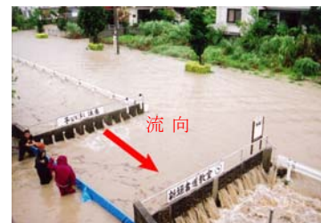
写真-2 現河川の氾濫状況
